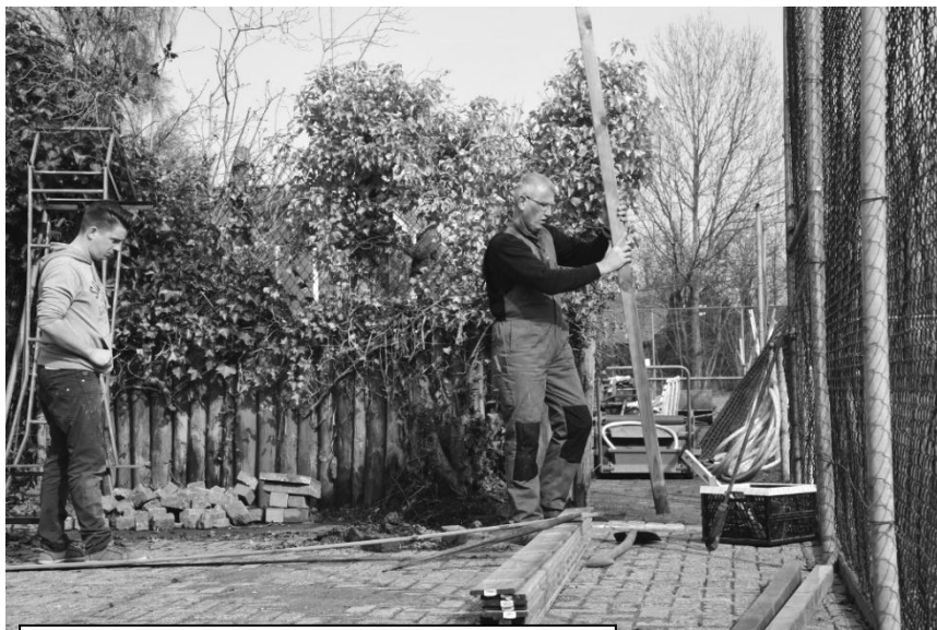
Jeroen en René bezig met de bouw van een afscheidingswand op baan 4
